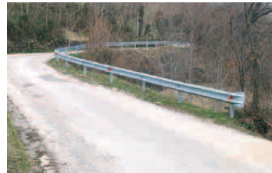
Nuovo guard-rail - via Chiarelli
